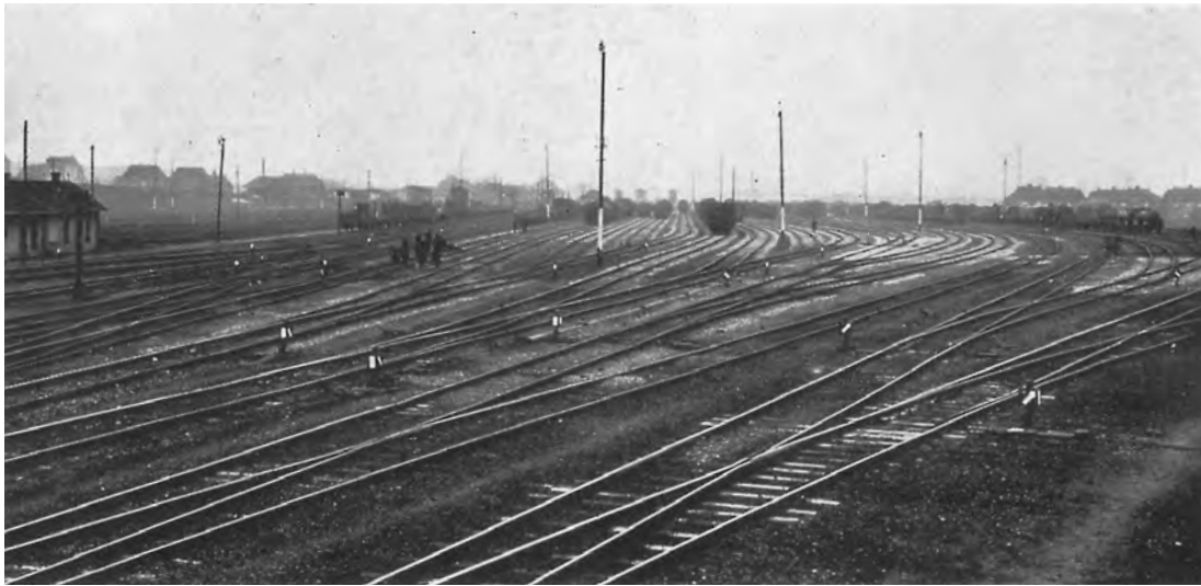
Rangier- und Verschiebebahnhof Osterfeld-Süd Ansicht der Sammelgleise
