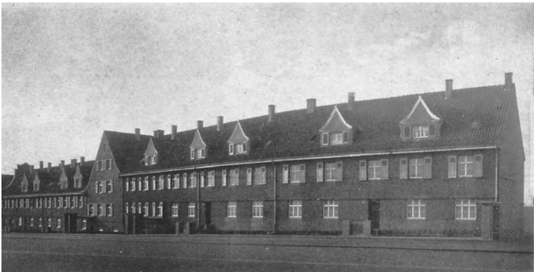
Osterfeld i. W., Schupowohnungen Waisenhausstraße
