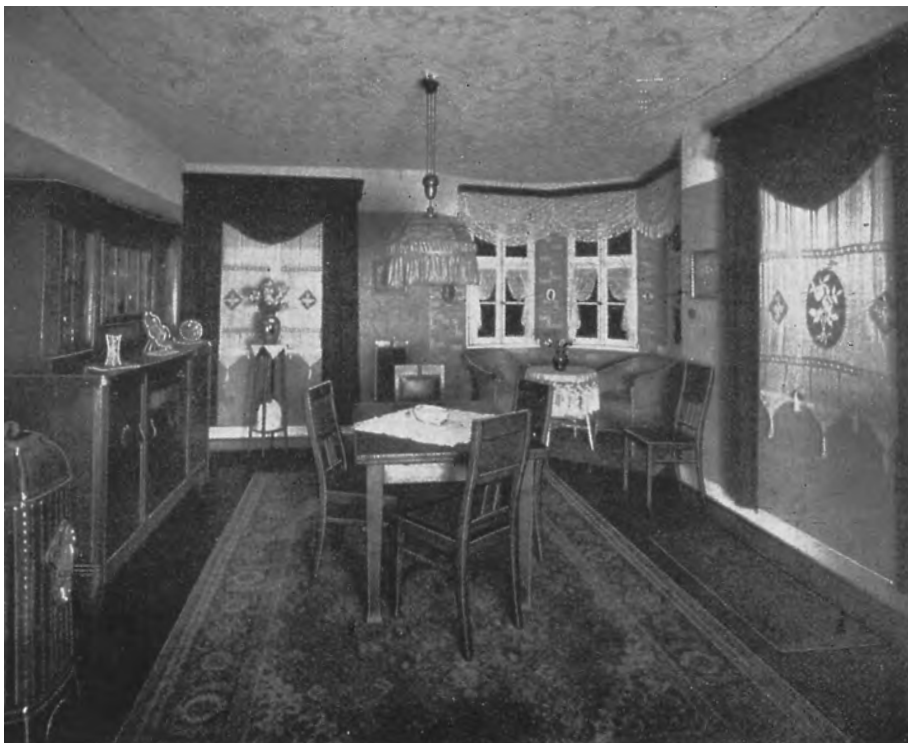
Esszimmer in der Baugruppe Waisenhausstraße, Osterfeld i. W. Erbaut 1926
