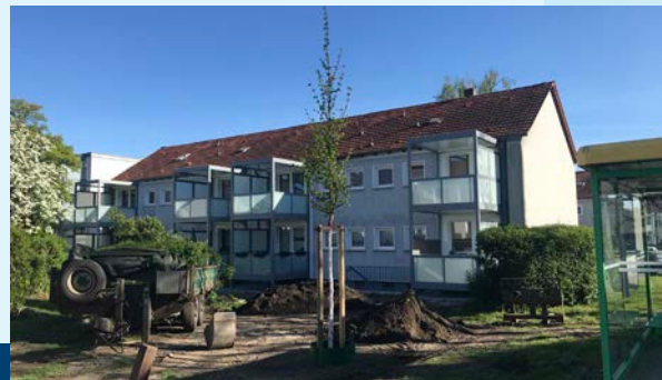
Die Wohnhäuser an der Herzogstraße während der Modernisierung
