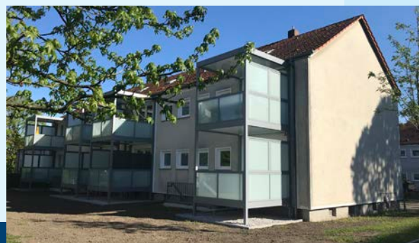
Die Wohnungsnutzer freuen sich über größere Aluminiumbalkone
