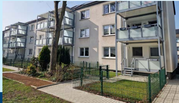
Die Häuser der Flöz-Matthias-Straße 63-67 erstrahlen in neuem Glanz
