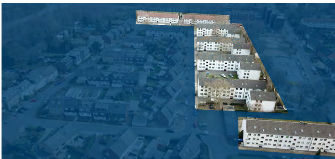
► Flexible Nahwärmeinseln für Wohnquartiere im Tackenberg
