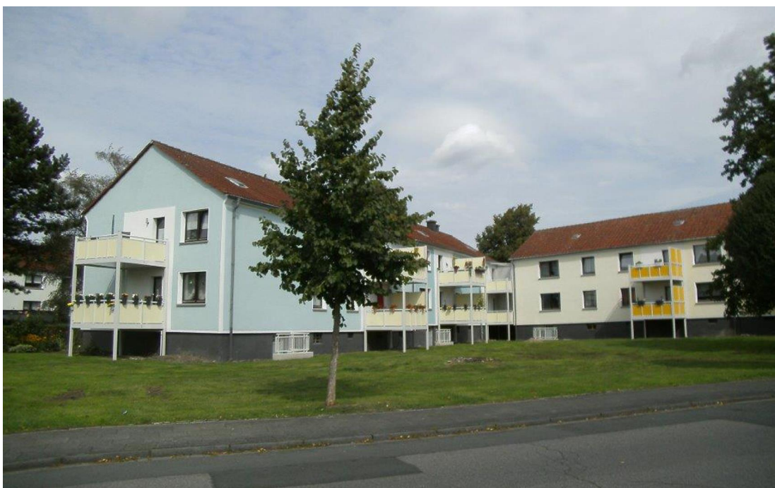
► Im Jahr 2014 wurden unter anderem die Balkone und Fassaden im Bereich der Ziegelstraße in Osterfeld erneuert. Die alten Balkone wurden durch neue, größere ersetzt.
