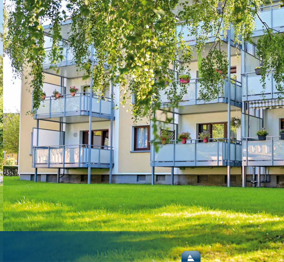
Modernisierung und Instandhaltung
